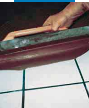
Aplicarea șapei autonivelante Ultraplan cu spatula metalică pe o pardoseală din plăci ceramice amorsată cu Mapeprim SP
