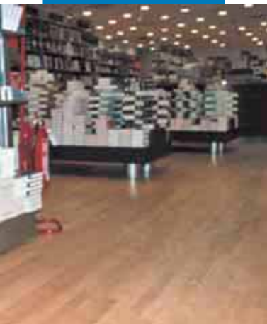
Exemplu de instalare a parchetului pe o suprafață nivelată cu Ultraplan - Messagerie Musicali - Roma - Italia
