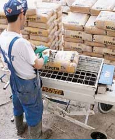
Realizarea amestecului Topcem cu malaxor orizontal având ax spiralat
