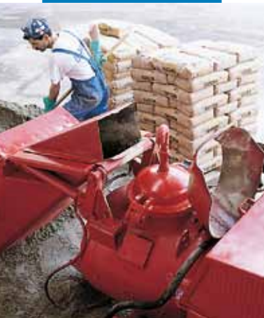
Realizarea amestecului Topcem cu o pompă automată cu presiune
