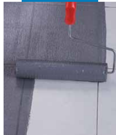
Aplicarea de Eco Prim Grip pe o pardoseală din plăci de gresie porțelanată, cu trafalet
