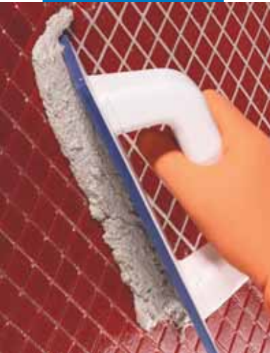
Aplicarea lui Kerapoxy Design cu ajutorul unei spatule din cauciuc pentru aplicarea chitului
