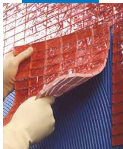
Lipirea mozaicului de sticlă cu Kerapoxy Design pe perete
