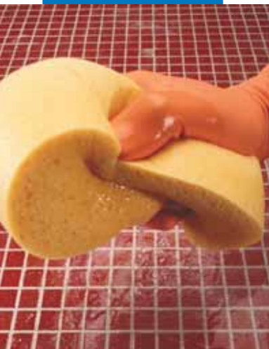
Umezirea suprafeței chituite înainte de curățare
